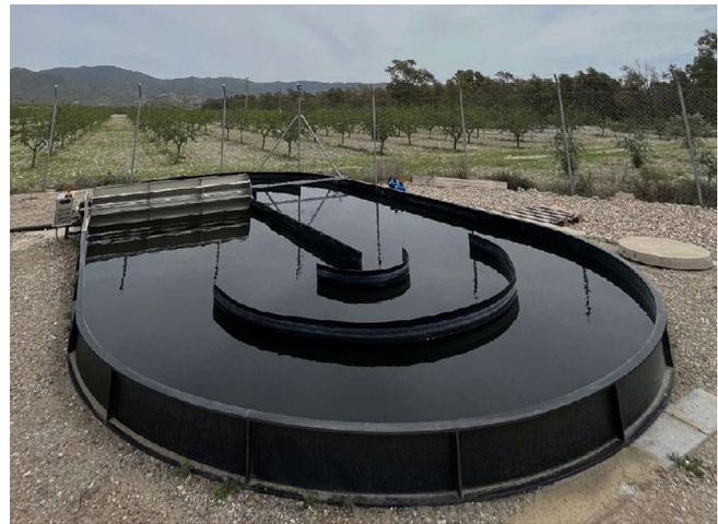
Fotorreactor extensivo (raceway) fabricado en polietileno de alta densidad existente en la actualidad en la EDAR de Uleila del Campo que será acondicionado para su uso.
